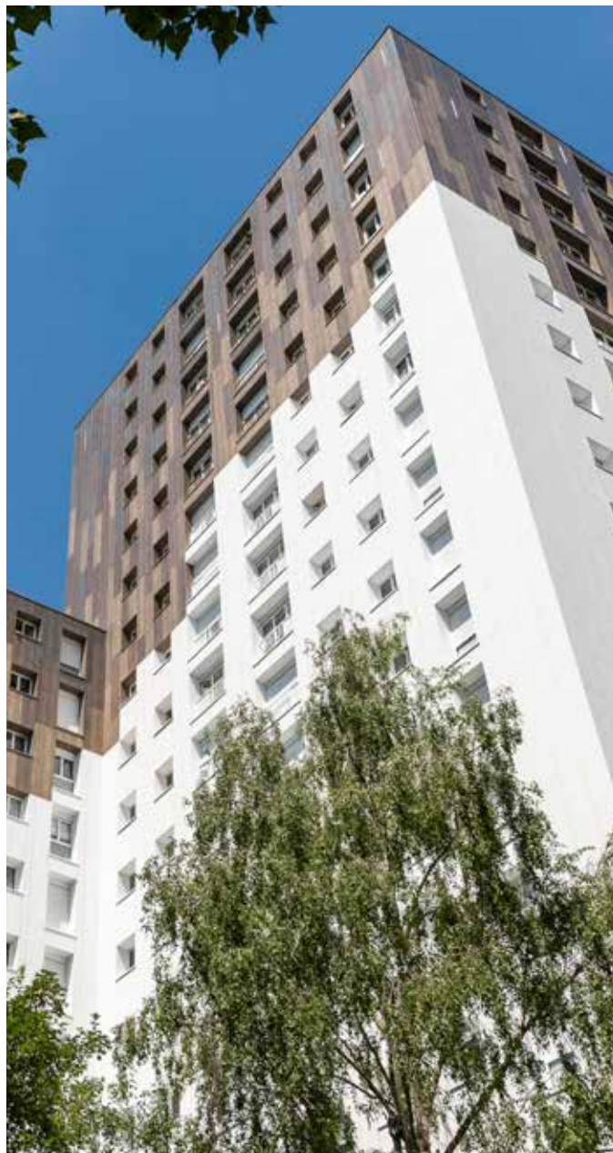
Après rénovation avec notre solution (sans bavettes)
